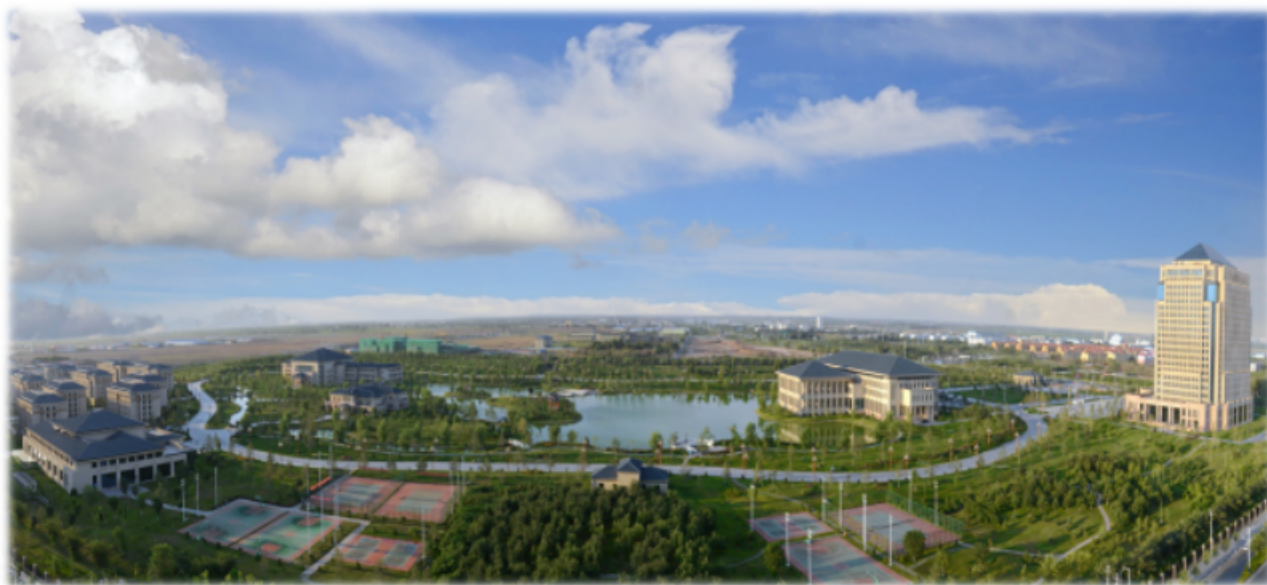
上图：特变电工商务区总部
