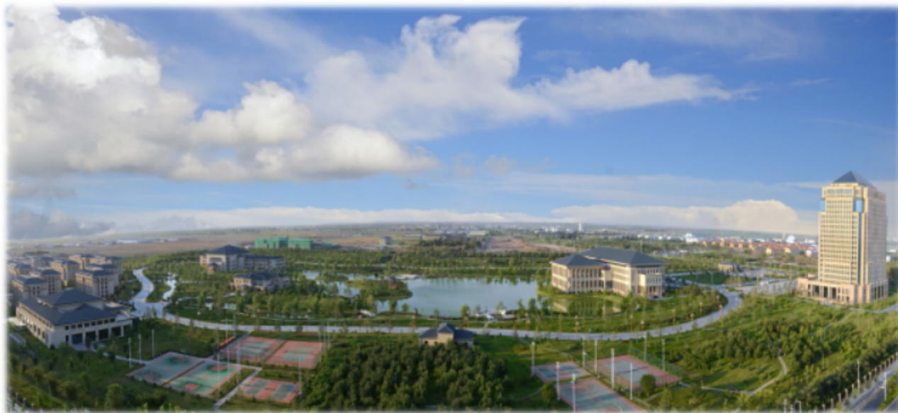
上图：特变电工商务区总部
